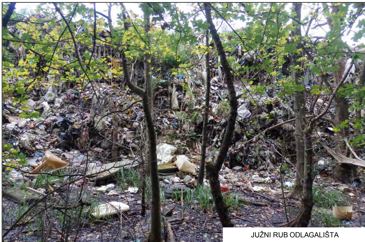
Slika 1.2-2: Odlagalište otpada Bukovina - postojeće stanje (nastavak)
